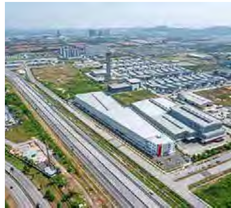
Bandar Bukit Raja by Sime Darby Property (Bukit Raja) Sdn Bhd
